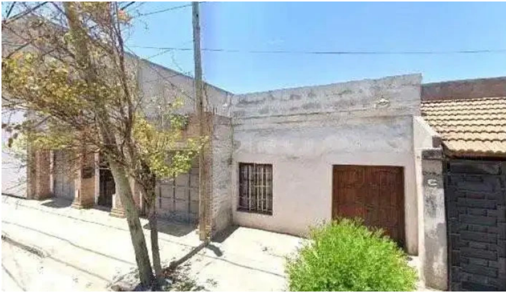
Filaxis kinesiologia y rehabilitacion ubicaciondeg
