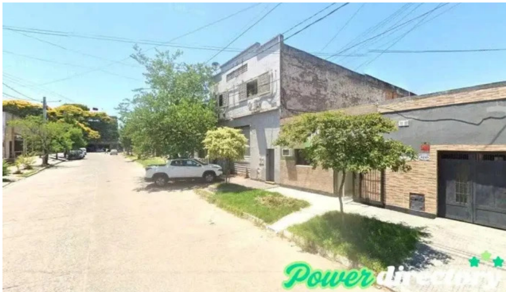
Rehabilitacion integral san miguel de tucuman
