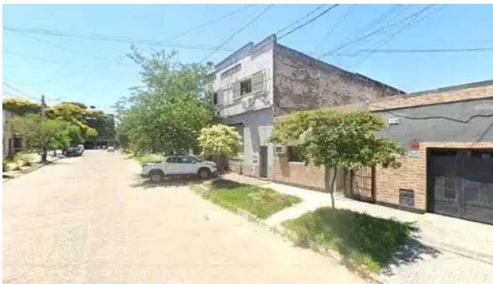
Rehabilitacion integral horario
