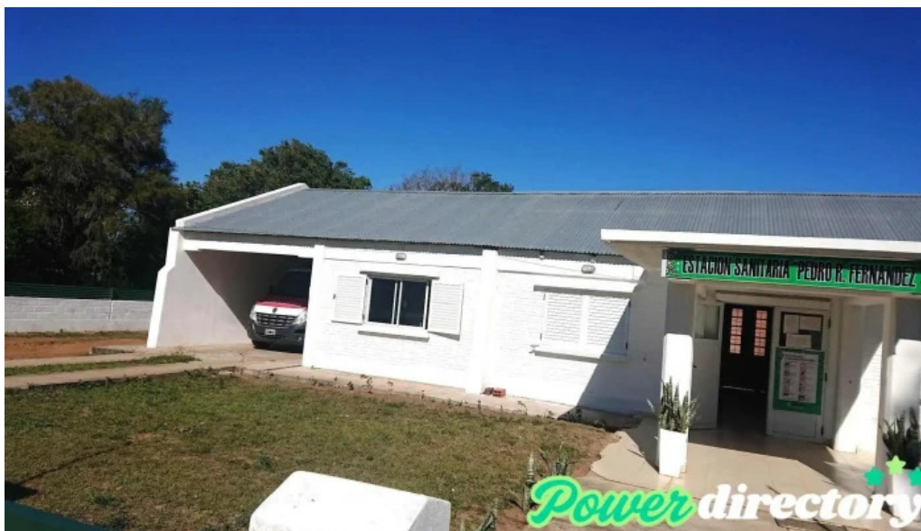
Estacion sanitaria pedro fernandez direccion
