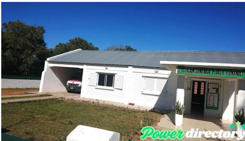
Estacion sanitaria pedro fernandez mantilla
