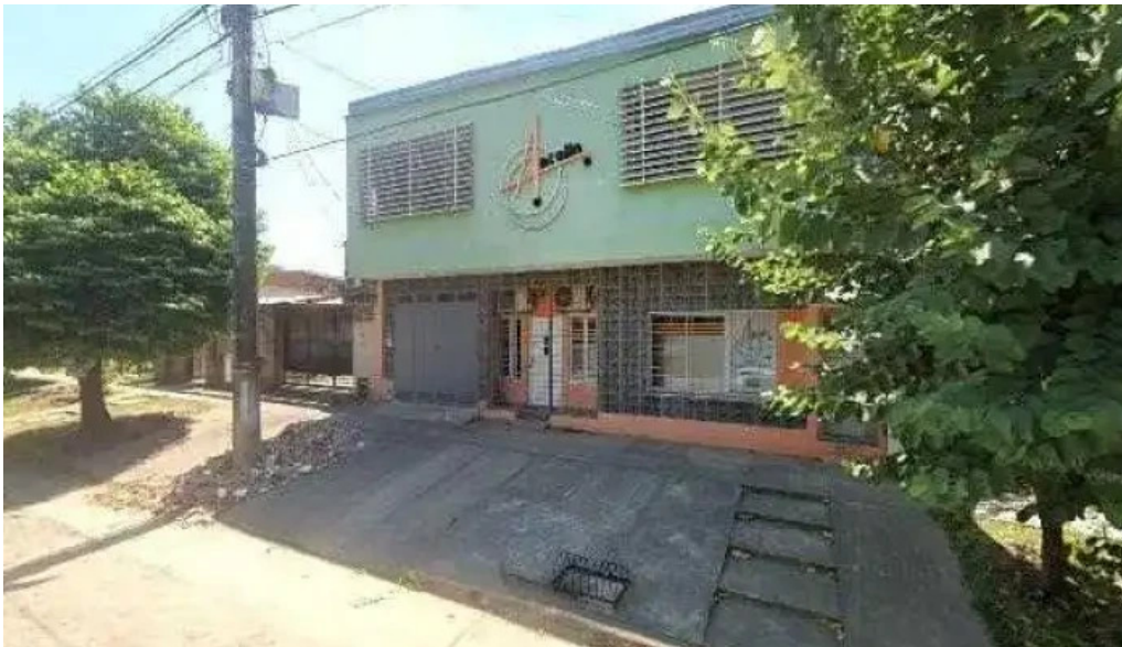
Antolin rehabilitacion integral telefono
