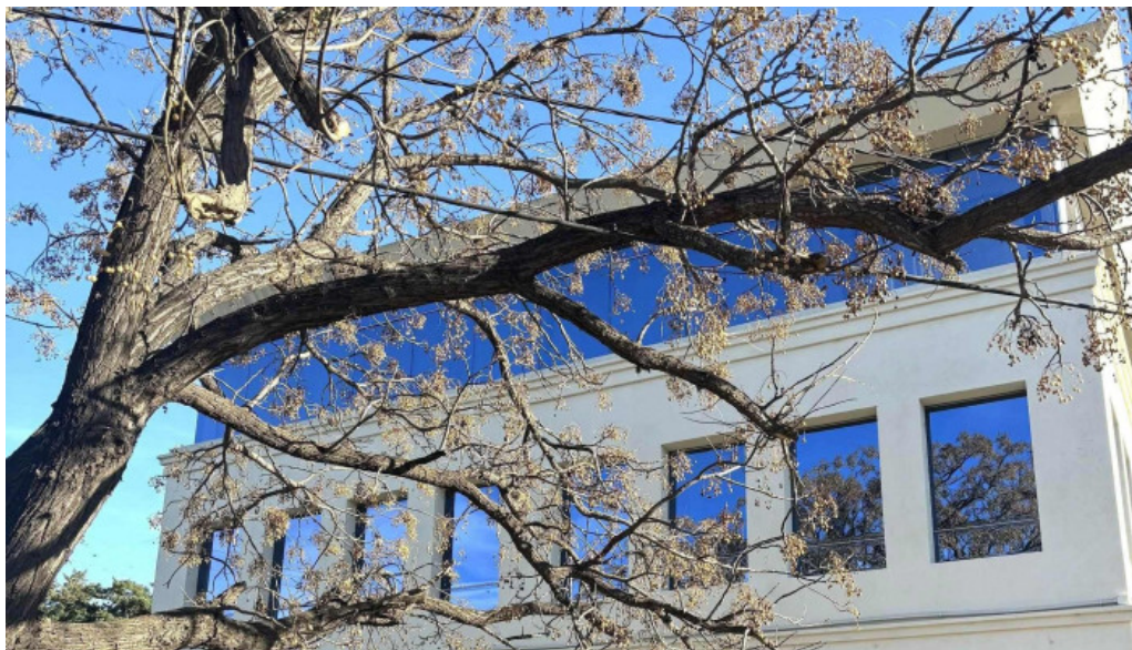
Cireha centro interdisciplinario de rehabilitacion fpj
