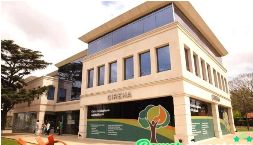
Cireha centro interdisciplinario de rehabilitacion fpj
