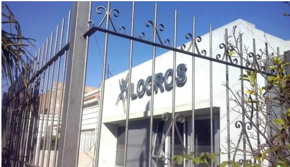
Logros centro privado de rehabilitacion neurologica puntaje
